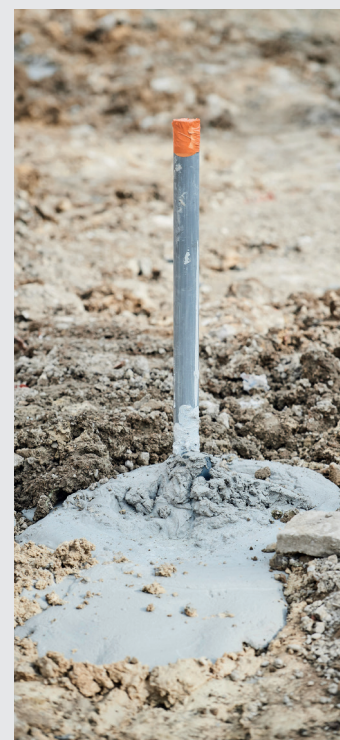
Consolidation du sol au travers d'injection de mortier via des tubes à manchon.
